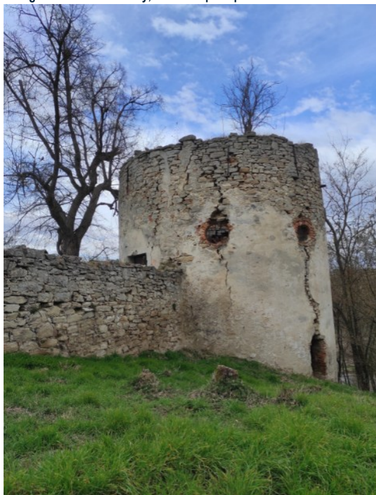
Fotografia 1. Nowe Kichary, baszta-kaplica pw. św.św. Rocha i Jacka
